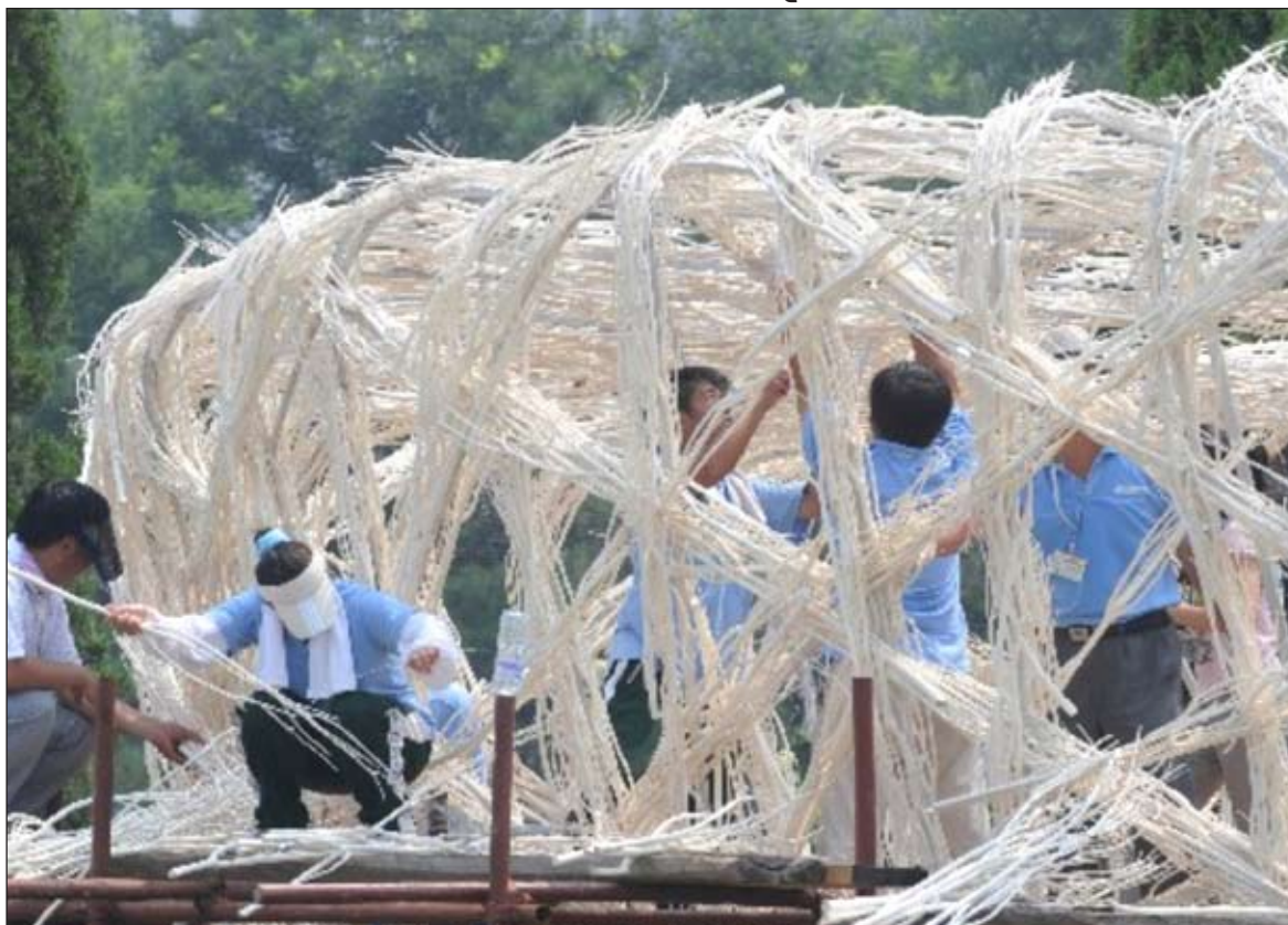
(تصویر ۵) آماده سازی ساختار مجسمه ی آشیانه ی پرنده جهت نصب و اجرا
