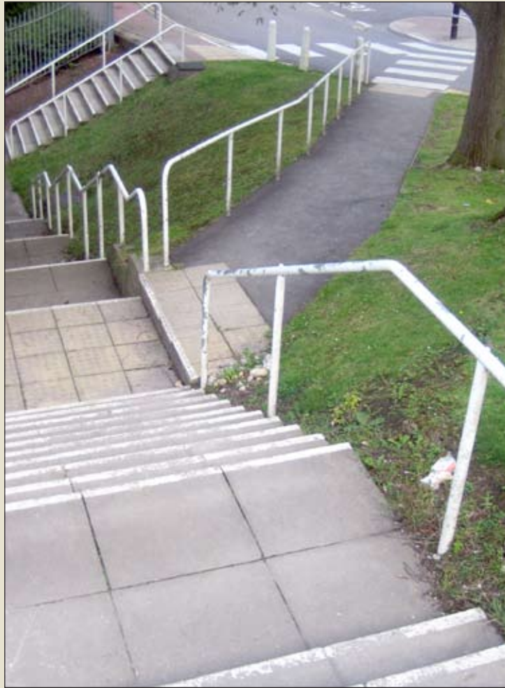
(تصویر ۳) اعمال رنگ سفید به لبه‌ی پله‌ها و نرده‌ها، به رؤیت بهتر آن‌ها در شب و زمان‌هایی که دید کم است کمک می‌کند.
